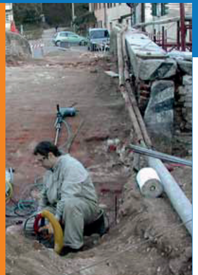
Inyección de la resina IDRO CP 200
