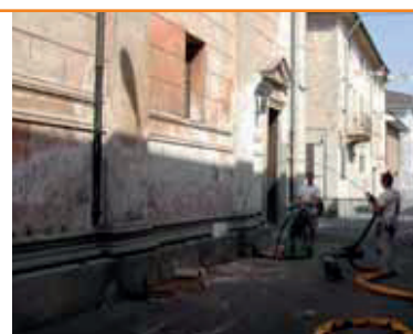
Inyección de resina bajo la cimentación perimetral
