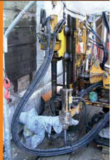
Sondeo en el terreno hasta 30 m de profundidad.
