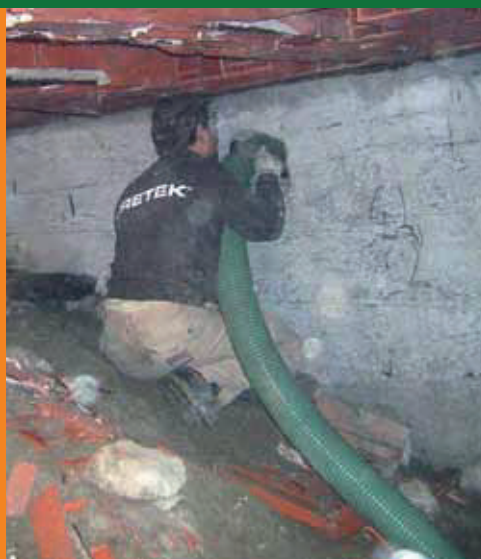
Colocación del tubo de bombeo de la arcilla expansa
