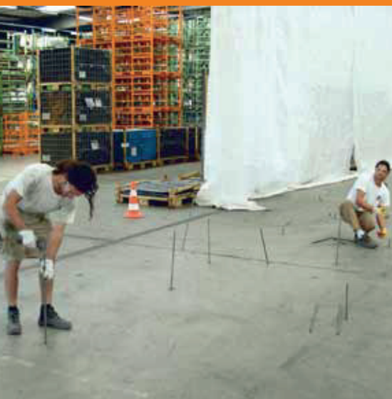
Perforación y colocación de los tubos de inyección de la resina
