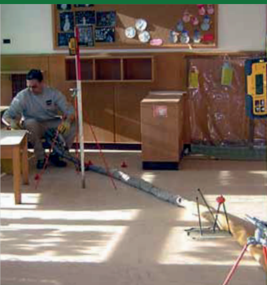
Inyección de resina Geoplus® en la cavidad a subyacente
