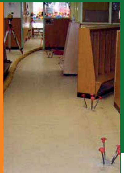
Tubos preparados para la inyección de resina
