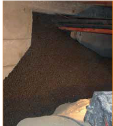
Montón de arcilla expandida durante el llenado de la cavidad.
