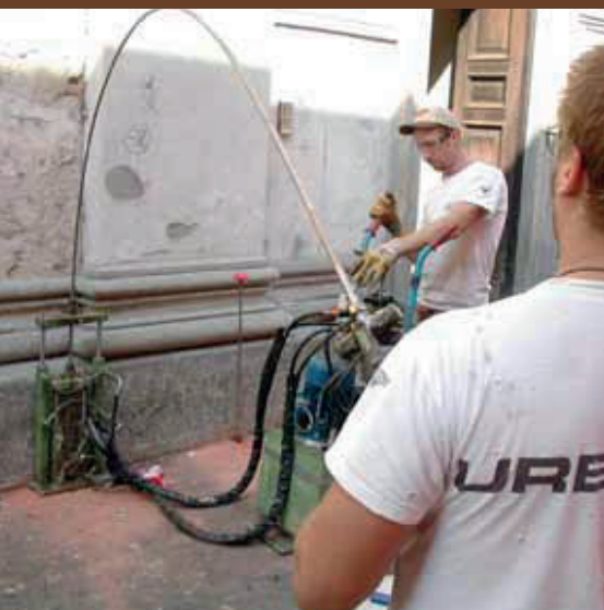
Inyección en columna
