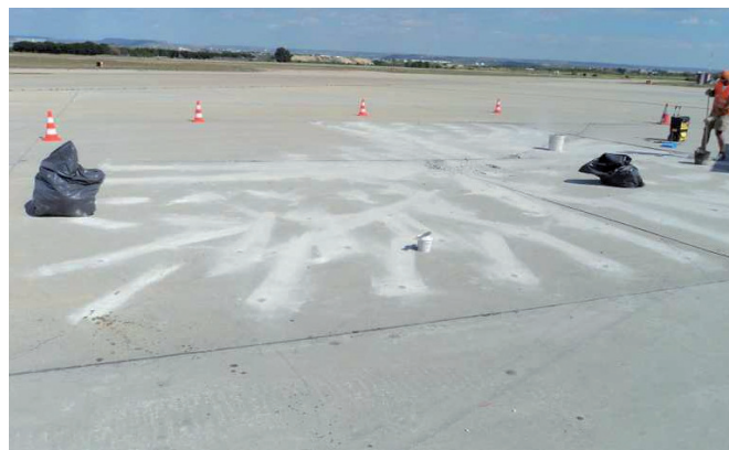
Estado final tras la intervención
