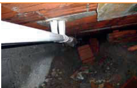
Interior de forjado sanitario, tubería de calefacción
