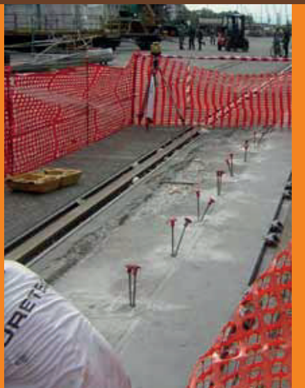
Tubos preparados para la fase de inyección
