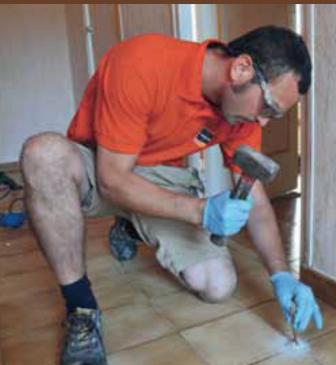
3 Introducción de tubos de inyección
