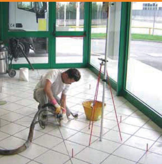
Inyecciones bajo pavimento
