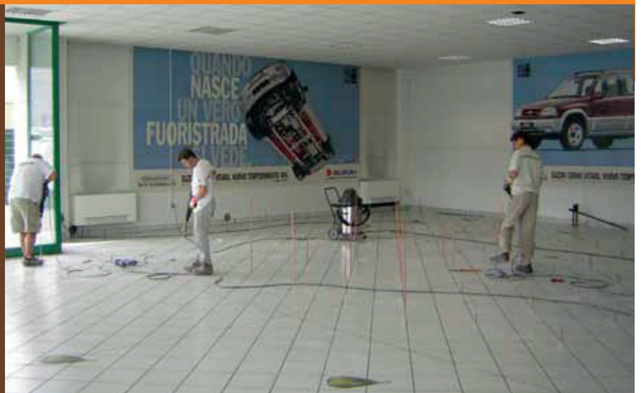
Técnicos de Uretek trabajando
