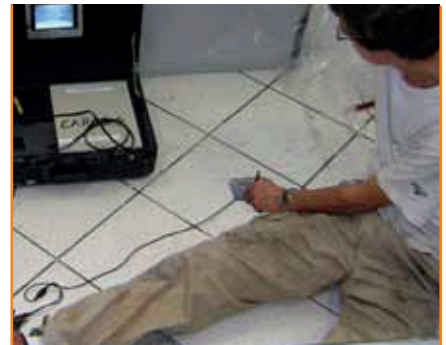
Inspección por vídeo para estimar huecos.
