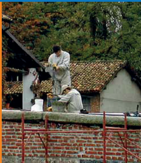
Perforación zona transitable
