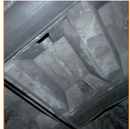
Detalle articulación de una bóveda.
