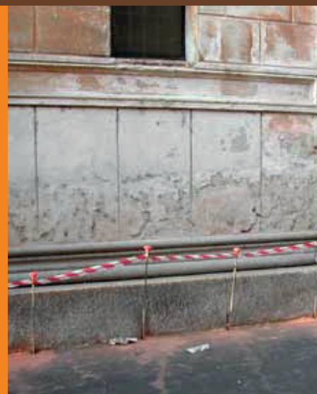
Puesta en obra de los tubos de inyección a intervalos regulares
