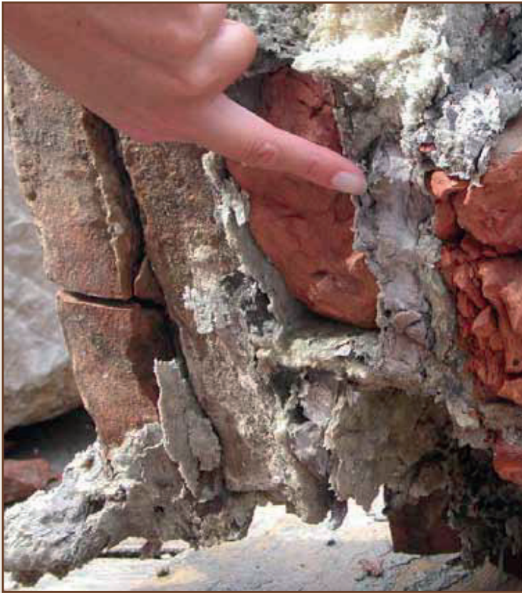
Vista del relleno de los huecos dentro de la mampostería.
