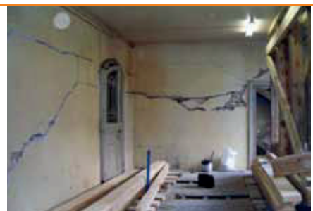
Brazos de apoyo de la solera para mantener el acceso al público.
