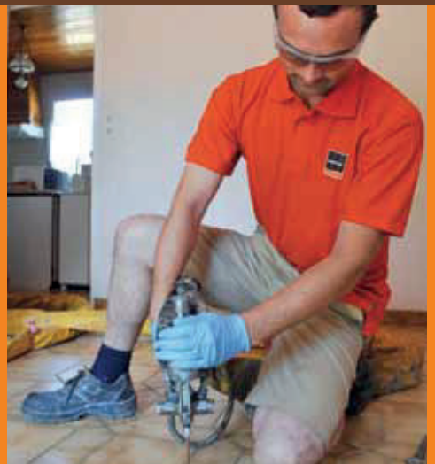
4 Inyección de la resina expansiva
