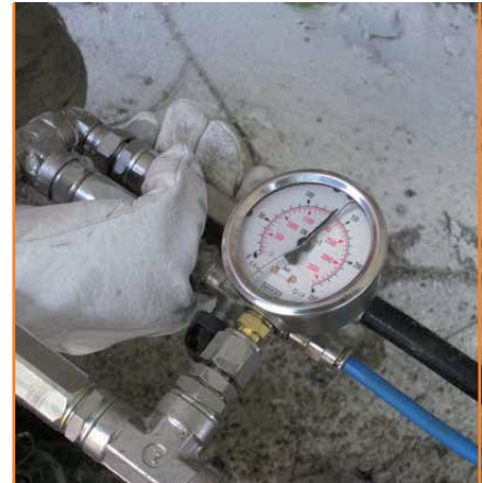
Manómetro especial de control de inyección.
