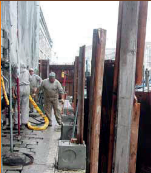
Técnicos de Uretek trabajando a lo largo del lado del edificio con vistas al Gran Canal.
