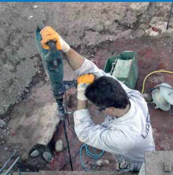
Detalle de la fase de perforación vertical
