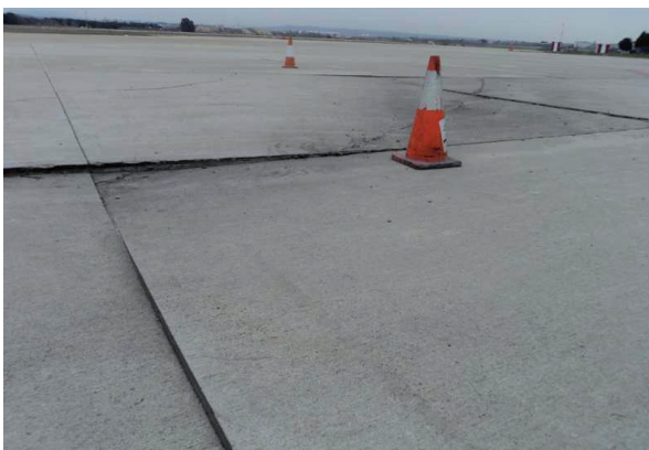
ESTADO INICIAL zona de contacto de losas
